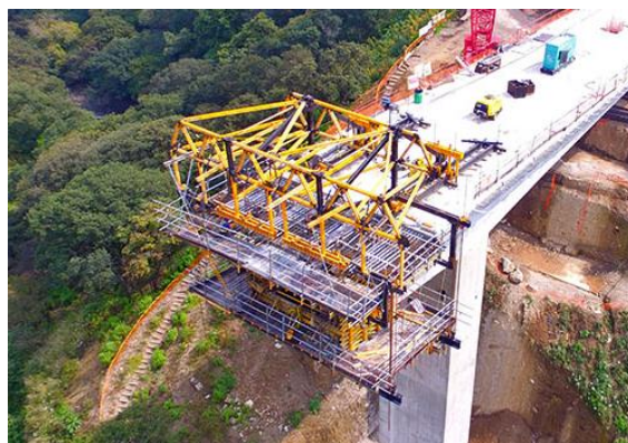
Figura 16: Carro de avanço para ponte construída em consolos sucessivos Fonte: (Ulma Group)
