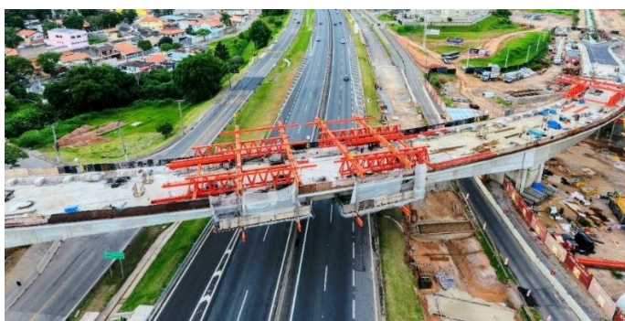
Figura 20: Encontro dos dois balanços na obra do Viaduto das Valquírias, em Jundiaí-SP Fonte: (Tribuna de Jundiaí, 2018)
