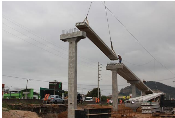
Figura 29: Passarela construída com lajes ocas Fonte: (JI News, 2016)
