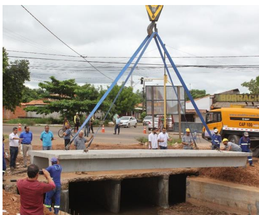
Figura 14: Içamento de viga pré-moldada para execução de ponte Fonte: (CARVALHO, 2019)
