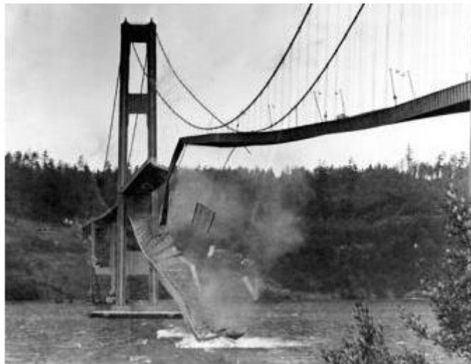
Figura 10: Colapso da Ponte Tacoma Narrows, nos EUA Fonte: (FERREIRA JÚNIOR)
