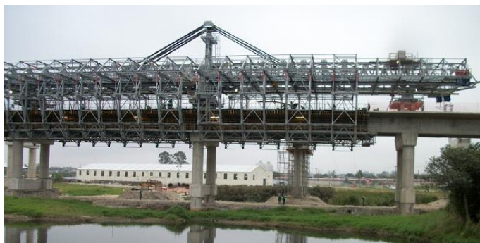
Figura 13: Exemplo de execução de ponte sobre cimbramento móvel sem apoios intermediários Fonte: (Portal Badra, 2013)
