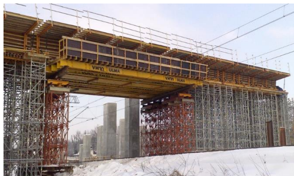
Figura 12: Rodovia S69 Bielsko Biala - Żywiec – Zwardoń, Polônia, construída sobre cimbramento fixo.
